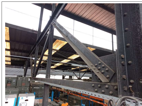
Prélèvement - P09 : Bâtiment 162 / Rez de chaussée / Local 10 - Peinture- (Présence d'amiante)
