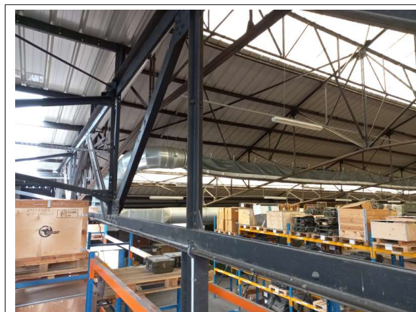
Prélèvement - P10 : Bâtiment 162 / Rez de chaussée / Local 10 - Peinture- (Présence d'amiante)
