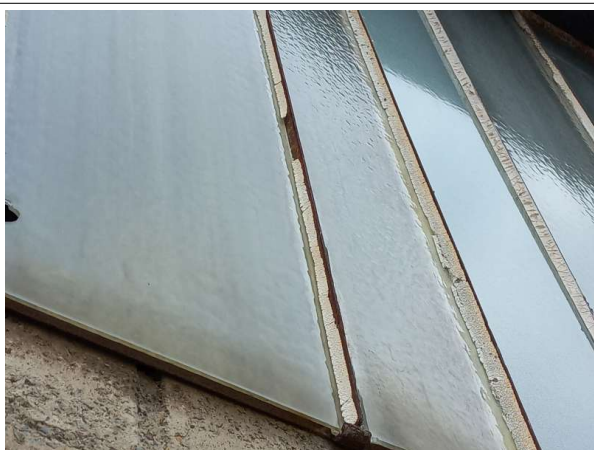
Prélèvement - P11 : Bâtiment 162 / Extérieur / Façades - Joint- (Absence d'amiante)
