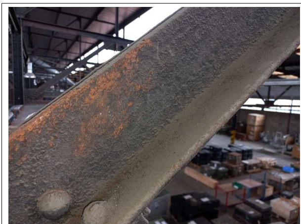
Prélèvement - P08 : Bâtiment 162 / Rez de chaussée / Local 10 - Peinture- (Absence d'amiante)
